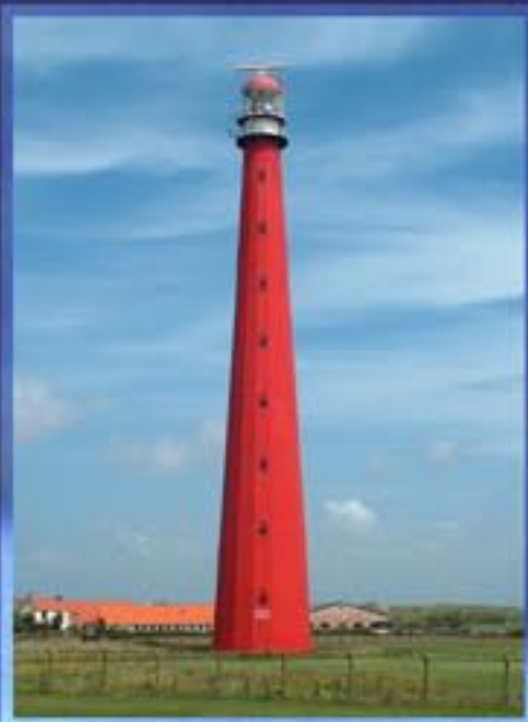
Lange Jaap Den Helder lichthoogte 57 m 16-kantige gietijzeren toren
