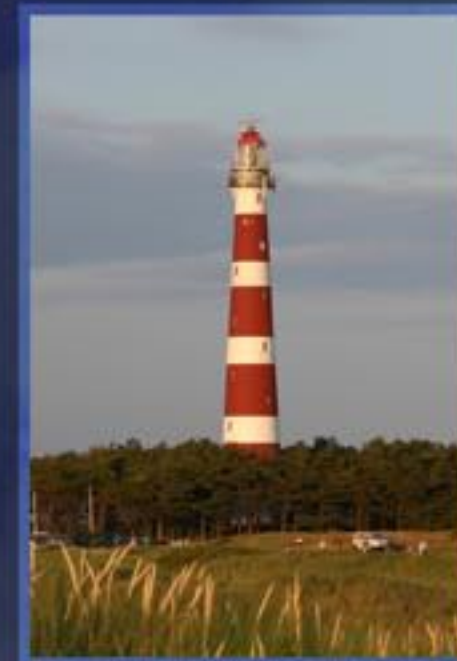
Bornrif Ameland lichthoogte 58 m gietijzeren toren
